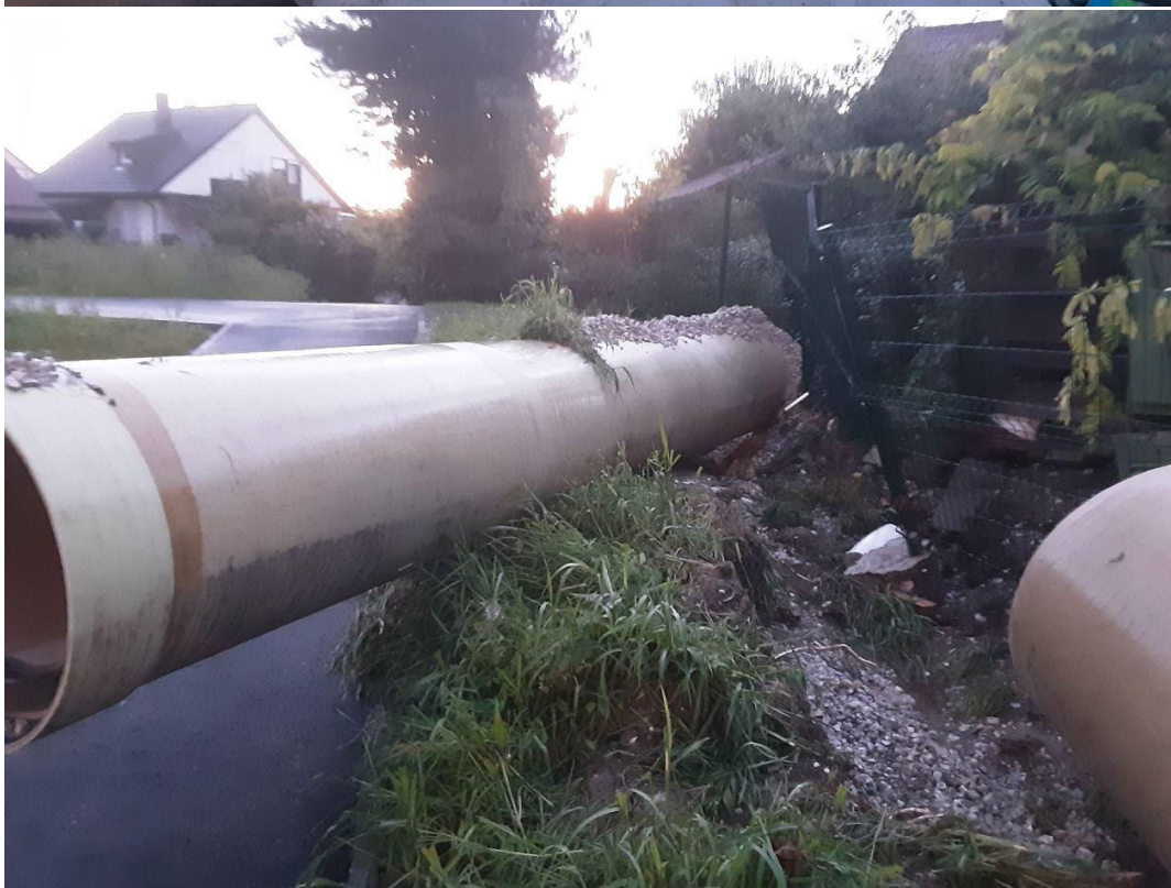
Slika 19 in 20. Naselje Sneberje plitko položen desni pritok Kanala C0 je »izplaval«
