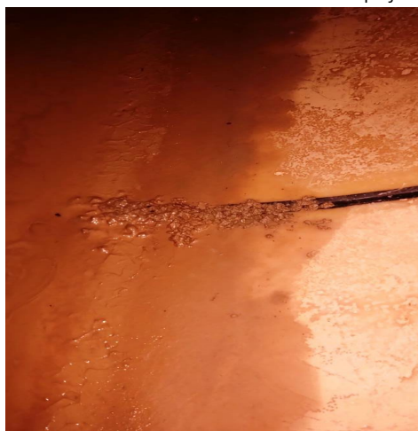
Slika 1. V cev že vdira voda ob večjem deževju in odlaga izprano zemljo, o čemer priča oblika odloženega blata na nekaterih spojih cevi. Ob suhem vremenu pa komaj zgrajena cev pušča tudi v nasprotno smer – v podtalnico.
